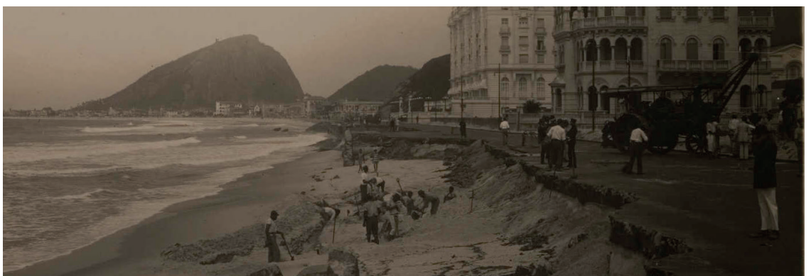
ressaca destrói a calçada em 1922
